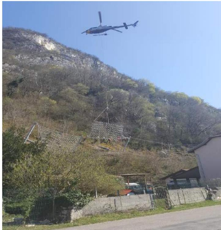
Les travaux ont débuté en Février dernier pour une durée approximative de 6 semaines par le renforcement du maillage existant avec la pose d'un écran ETAG 2000 kj en amont de l'écran. 12 ml ont également été posés en rallonge afin de parfaire le recouvrement avec l'écran amont et ainsi éviter tout risque de contournement.
