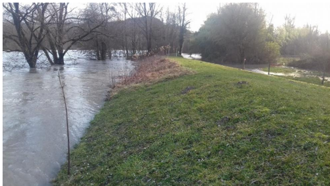
Crue de Janvier 2018 – Massignieu-de-Rives
